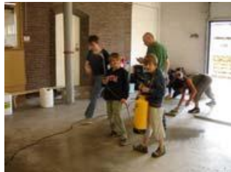
Распыление; очистка с помощью Cleaner; сушка через 10 минут.
